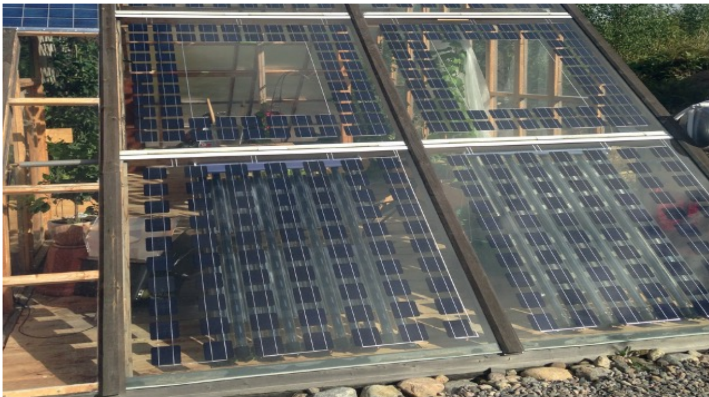
Solceller kan användas som solavskärmning, här är solcellerna placerade på ett uterum. Foto: L. Karlsson
