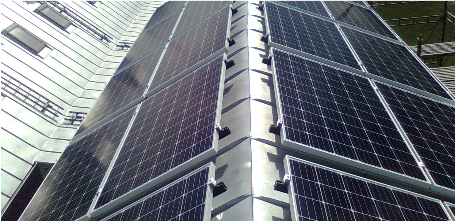
Exempel på anläggning med svag taklutning i ett öst-västläge. Foto: L. Ivarsson
