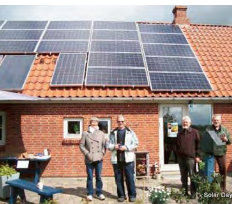
Förskjutet placering av paneler och paneler på olika håll kan ge ett brokigt intryck.
