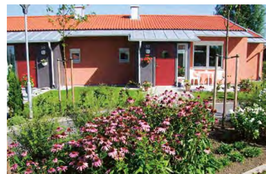
Passivhusen i Glumslöv har en meter långa takutsprång, som med sin skugga dämpar solvärmestrålningen under sommarhalvåret.
