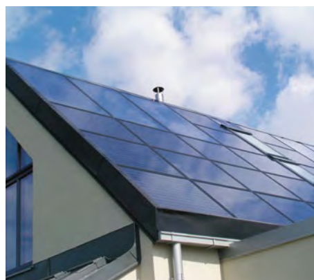
Plusenergihuset Villa Åkarp, med sina 18 m 2 solfångare och 32 m 2 solceller. Solcellerna producerar mer el än vad huset gör av med.
