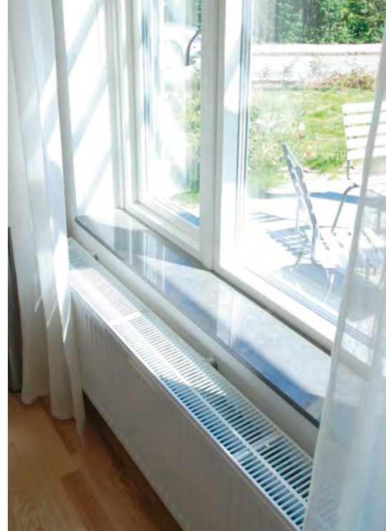
För att radiatorer inte ska behövas under fönstren bör U-värdet vara 1,0 \text{ W/m}^2 \cdot \text{K} för hela fönsterkonstruktionen.
