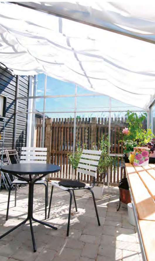
Ett fasadväxthus ger ett extra värmestillskott från den instrålade solen och fungerar som en värmesluss mellan ute och inne.
