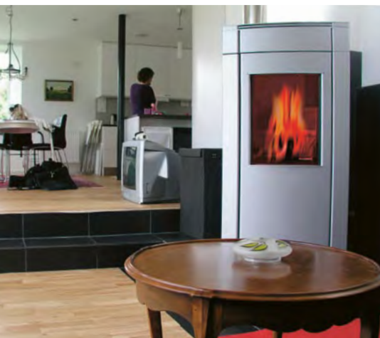
Med en pelletskamin kan man med fördel ha sin värmekälla placerad mitt i vardagsrummet.
