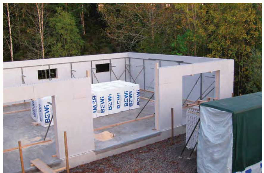
Ytterväggarna är 47 cm tjocka, uppbyggda av cellplastblock fyllda med 14 cm betong för att slippa skarvar, samt ytterligare 5 cm frigolitisolering både på insida och utsida.
